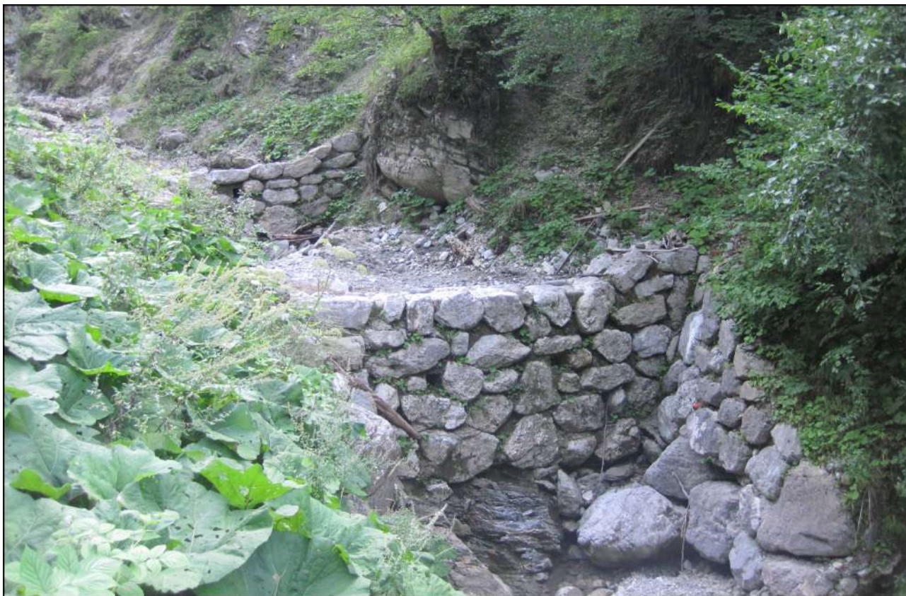
Slika 5: V zgornjih odsekih hudourniški potoki presušijo, na njih pa so tudi zgrajene pregrade za zadrževanje proda. (foto: Marijan Govedič, 27. 8. 2020)
