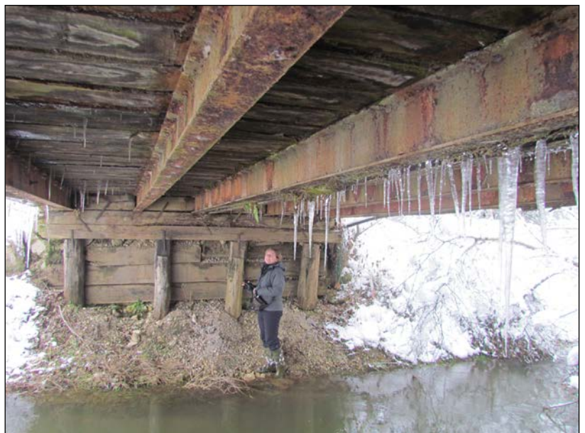
Slika 13.2. Pregled bregov Voglajne pod mostom na iztoku iz Slivniškega jezera (foto: P. Prešetnik, 18.1.2014).
